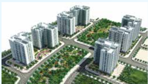
Chung cư Phong Bắc, Đà Nẵng
