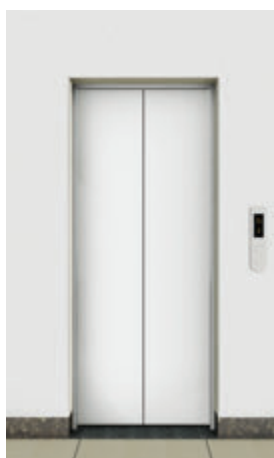
Cửa tầng chính Lobby
