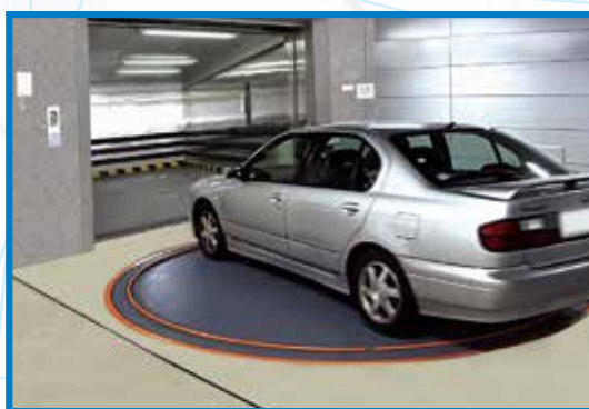
Thang tải xe hơi kết hợp với mâm xoay
