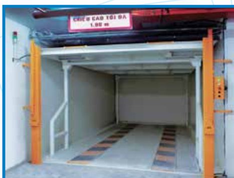
Bàn nâng xe hơi thủy lực, thường dùng trong các công trình: cao ốc văn phòng, trung tâm thương mại có tần suất hoạt động không cao
